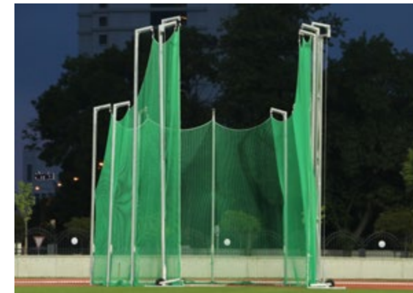
Abb.: Kombiniertes Schutzgitter von 7 auf 10 m ansteigend
