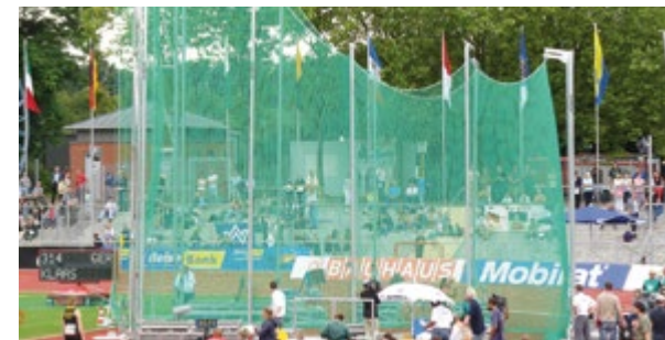
Abb.: Kombiniertes Schutzgitter von 7 auf 10 m ansteigend
