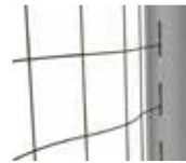
Eingefräste Netzaufhängung
