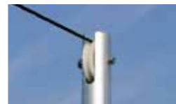
Umlenkrolle an den Spannstangen
