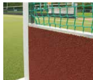
Eingegossener, schallschluckender Belag.
