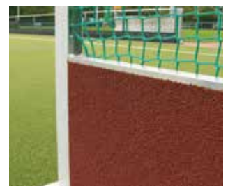
Eingegossener, schallschluckender Belag.
