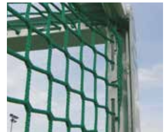
Eingefräste Netzaufhängung.
