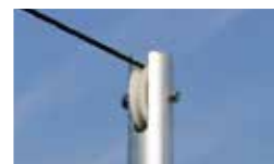
Umlenkrolle an den Spannstrangen
