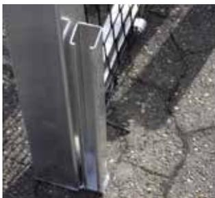
Aufnahme zum Einhängen der Bandenelemente an das Tor.
