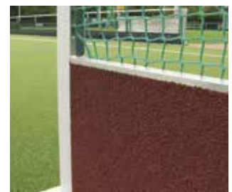
Eingegossener, schallschluckender Belag.
