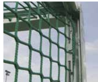
Eingefräste Netzaufhängung.
