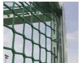
Eingefräste Netzaufhängung.
