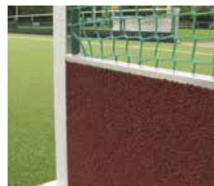
Eingegossener, schallschluckender Belag.
