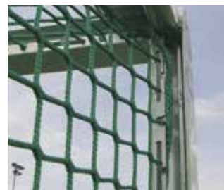
Eingefräste Netzaufhängung.
