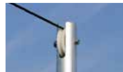
Umlenkrolle an den Spannstrangen
