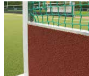
Eingegossener, schallschluckender Belag.
