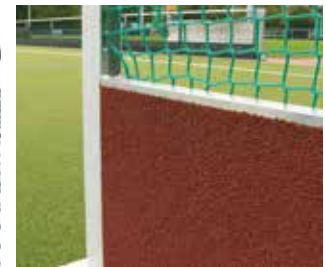
Eingegossener, schallschluckender Belag.
