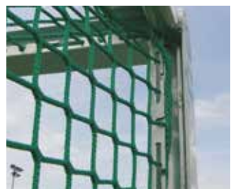
Eingefräste Netzaufhängung.
